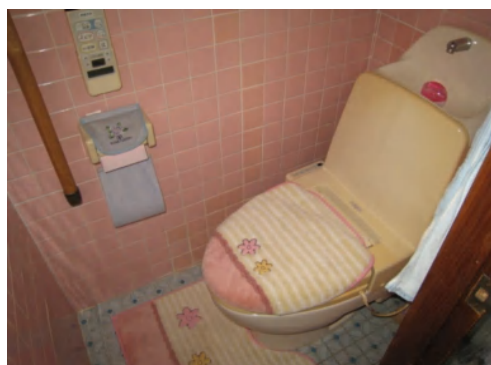
トイレの改修
